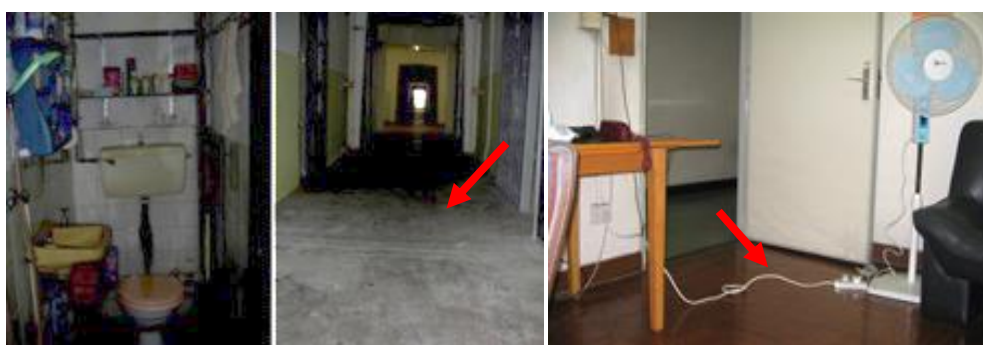
圖 1：房間光線較暗，地面濕滑，電線與插板置於入口處
