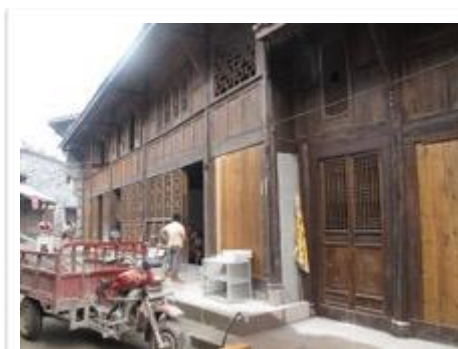
房屋改造前后
