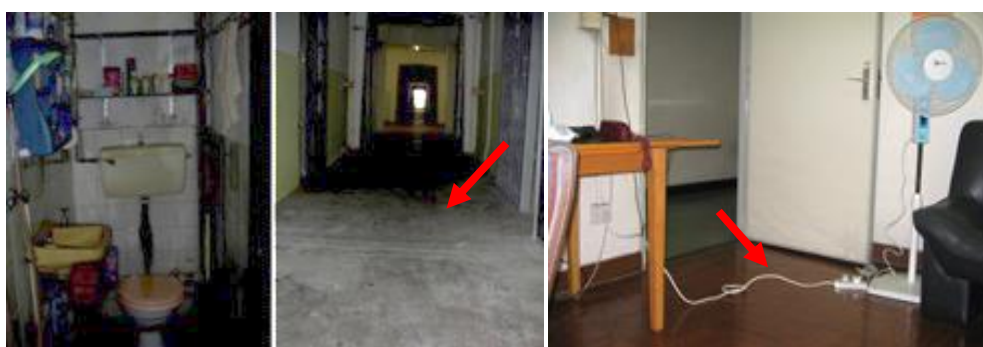
图 1：房间光线较暗，地面湿滑，电线与插板置于入口处
