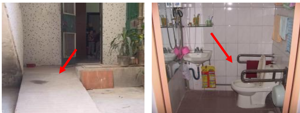
图 4: 门口台阶改成斜坡、卫生间安装带扶手的坐厕
